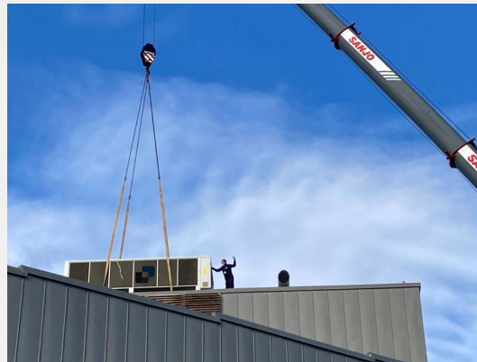
Inici de les obres de substitució dels equips de fred. Début des travaux de remplacement des équipements de climatisation.
